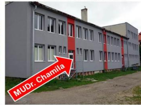
MUDr. Igor Chamila Lesná ul. - budova kult. domu (zadný vchod)
